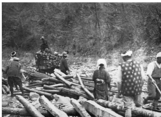
芳川山軌道敷設の作業
