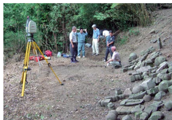
レーザー測量作業
