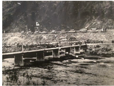
江師沈下橋の落成と森林軌道
