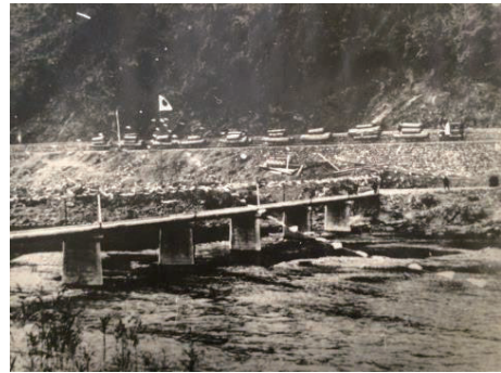
江師沈下橋の落成と森林軌道
