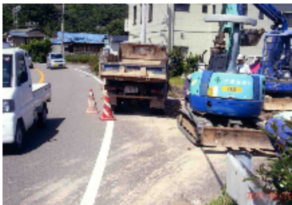
【写真：水道工事（生見）】
