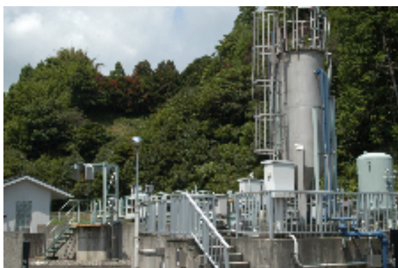
【写真：甲浦浄化センター（甲浦）】
