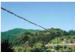
空とぶ水道管
