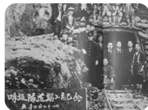
トンネル開通!
