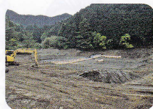
ため池は現在改修中
