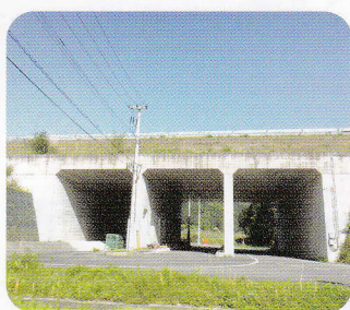
地区の真ん中を走る高知道との立体交差は、ため池が万が一決壊した場合に備えて、空間を大きくとっている
