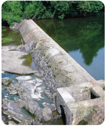
富岡橋の下にある堰
